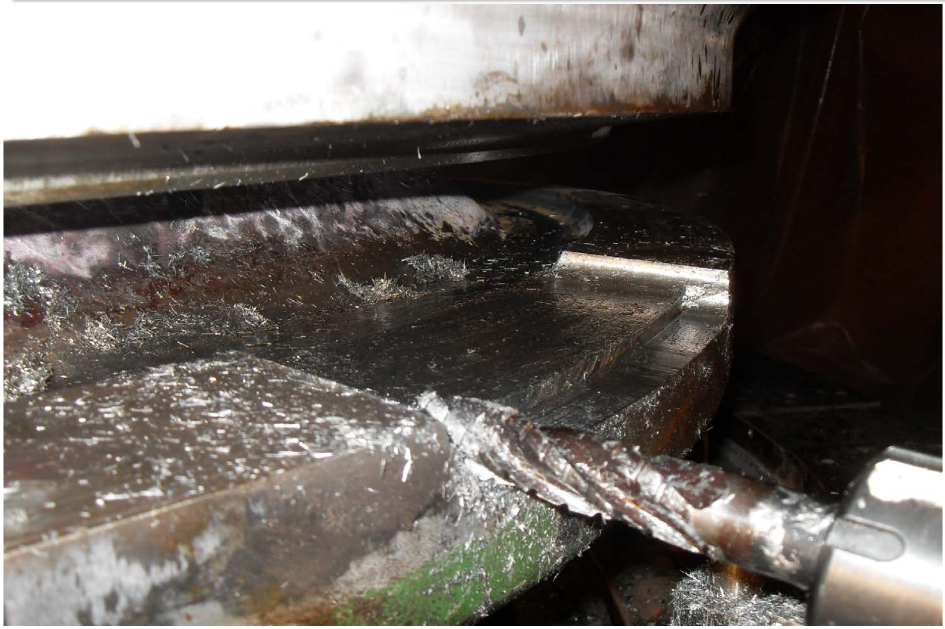
Экспериментальная отработка технологических операций механической обработки ремонтной разделки на узле приварки коллектора теплоносителя к патрубку Ду1200 парогенератора ПГВ-1000М средствами КСО производства АО «ГМЗ «ХИММАШ» в ЛСС на Нововоронежской АЭС. Фрезерование местной выборки в кольцевой разделке
